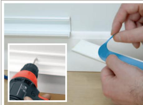
**Installation simple.** L'installation est simple et rapide. Il suffit de retirer le film de protection puis de coller l'article D-Line. Cette installation peut également se faire en perçant des trous et en y introduisant des vis.
