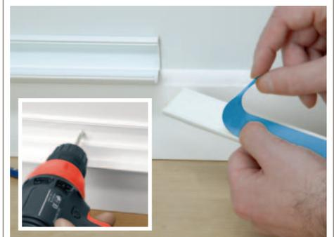
**Einfache Installation.** Der Klebestreifen an der Rückseite ermöglicht eine schnelle, leichte Montage. Bei Bedarf können die Kabelkanäle von D-Line zusätzlich an der Wand angeschraubt werden.
